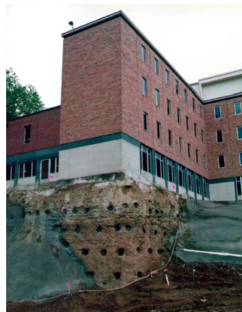
Рис. 9. Ограждение котлованов, выполненное с применением струйной технологии.
