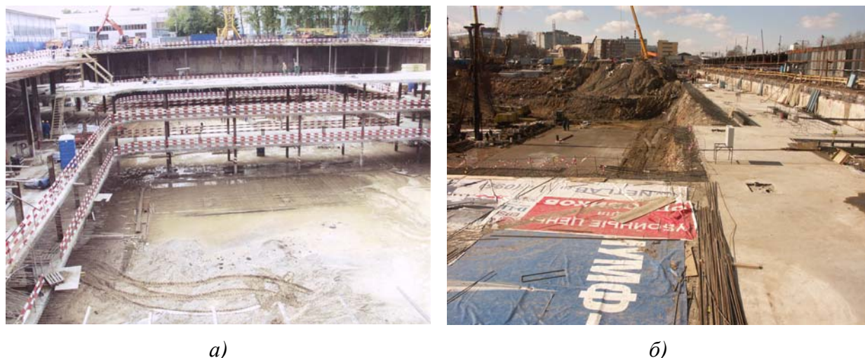
Рис. 20. Комбинированный способ строительства «semy-top-down».
