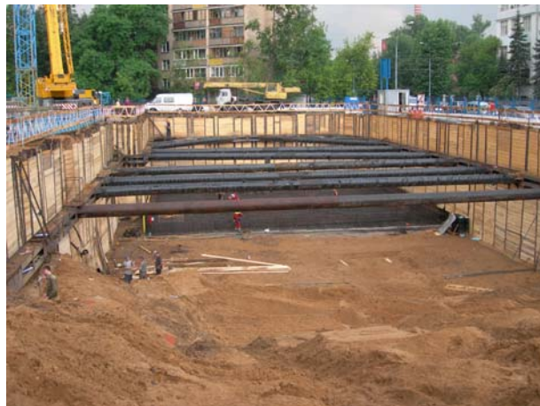
Рис. 4. Ограждение котлована из стальных элементов с забиркой.
