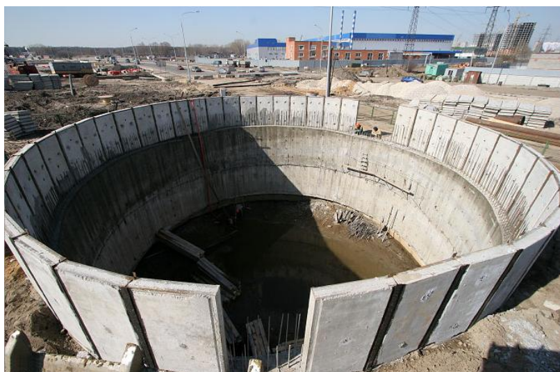
Рис. 3. Погружение сборно-монолитного опускного колодца.
