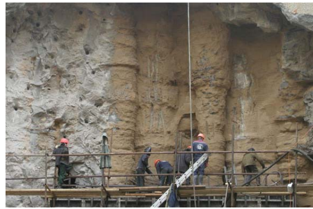
Рис. 9. Ограждение котлованов, выполненное с применением струйной технологии.
