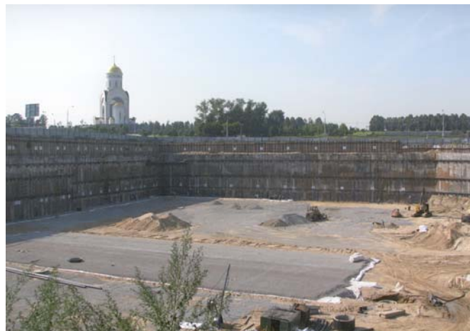
Рис. 13. Схема анкерного крепления (а) и котлован (б) московского Океанариума на Поклонной горе.
