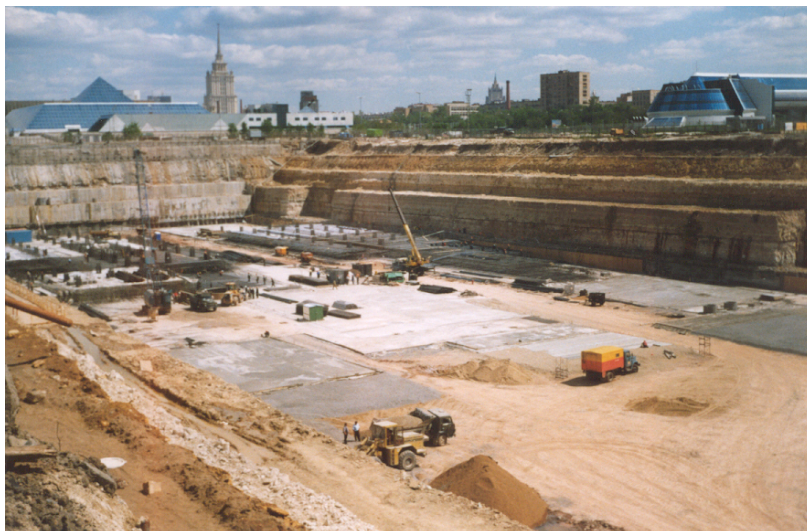
Рис. 1. Котлован Центрального ядра Международного центра «Москва-Сити» (1999)
